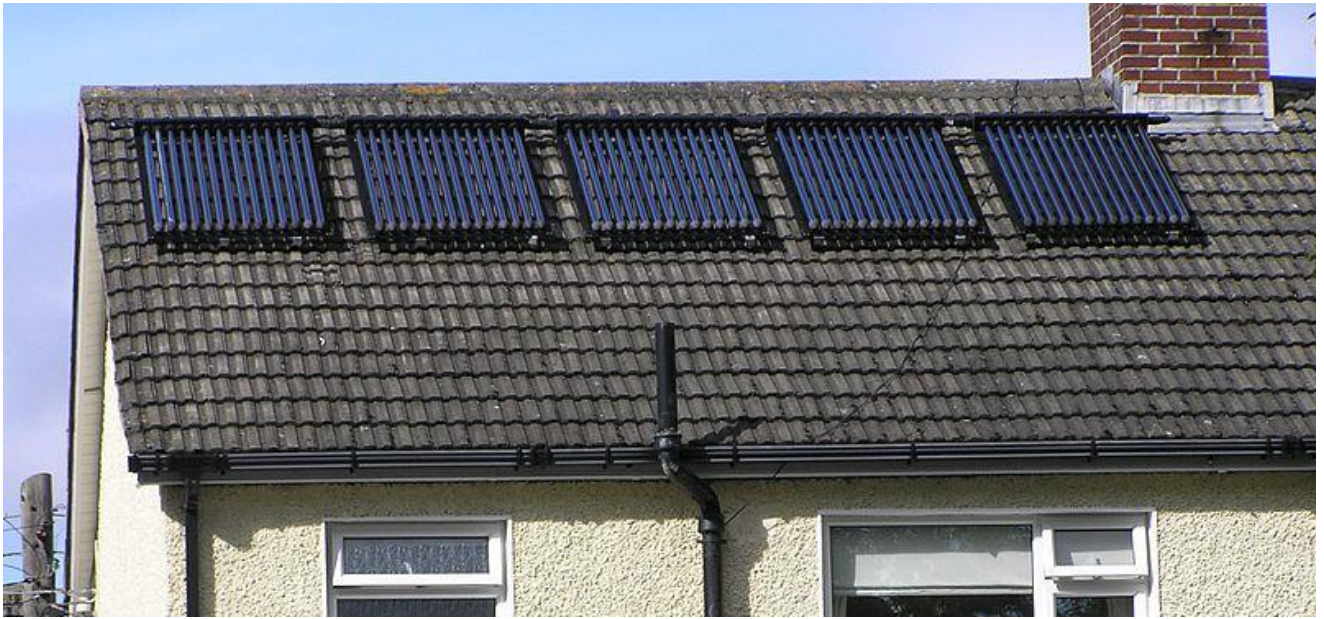
Ffigur 5 Paneli dŵr poeth solar domestig (Hawlfraint Terence Wiki ac wedi'i drwyddedu i'w aildefnyddio o dan Trwydded Creative Commons )
